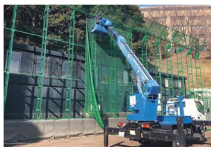
金網製バックネット改修工事
