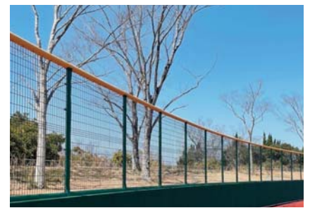
ホームラン識別パッド工事
