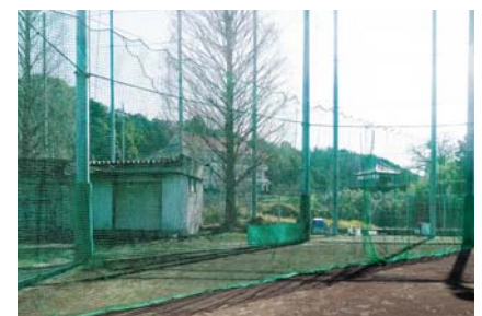
カーテン・ティネット設置工事
