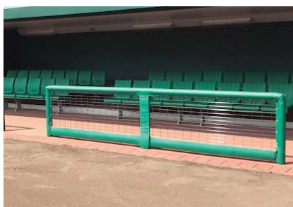
ダグアウト前フェンスパッド工事
