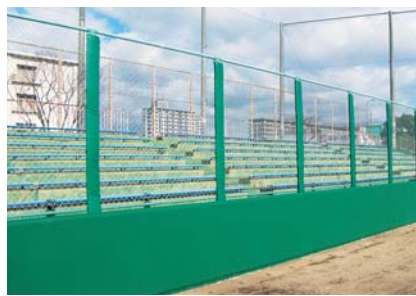
フェンス支柱防護パッド工事
